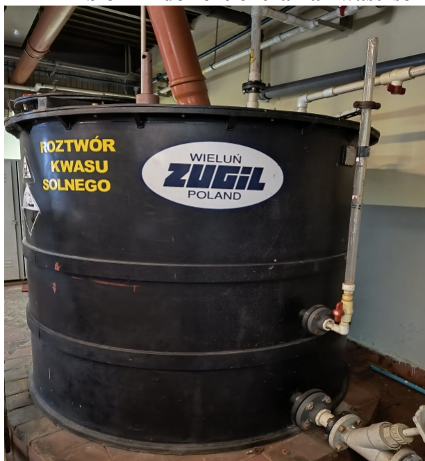
24. Zbiornik do rozcieńczania kwasu solnego. V=3\text{ m}^3 . Rok budowy 1998.
