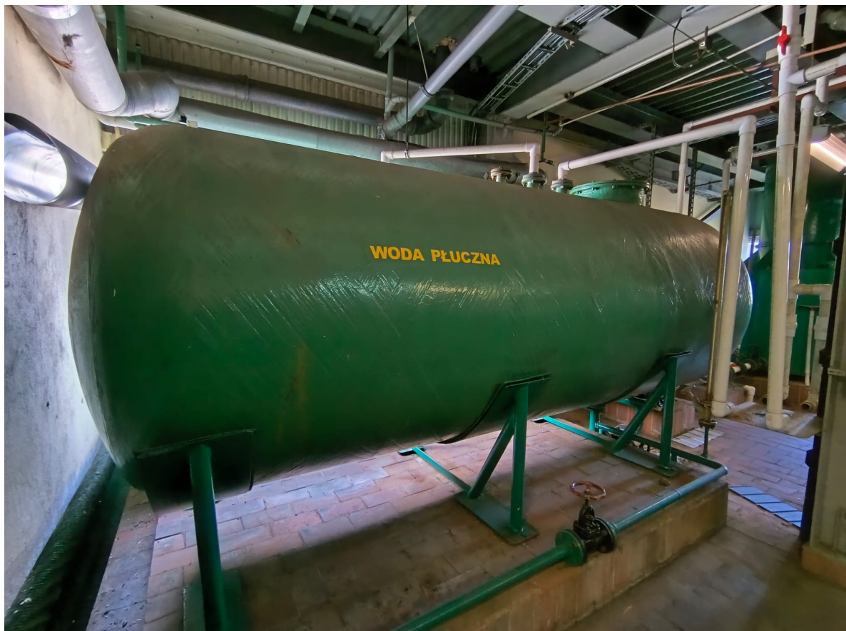
24. Zbiornik do rozcieńczania kwasu solnego. V=3\text{ m}^3 . Rok budowy 1998.
